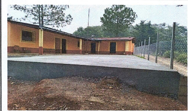
Foto 1: Mejoramiento de losa de patio
