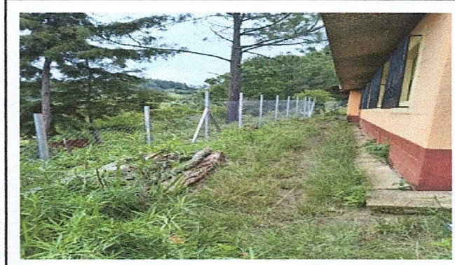
Foto 2: Mejoramiento de cerco perimetral
